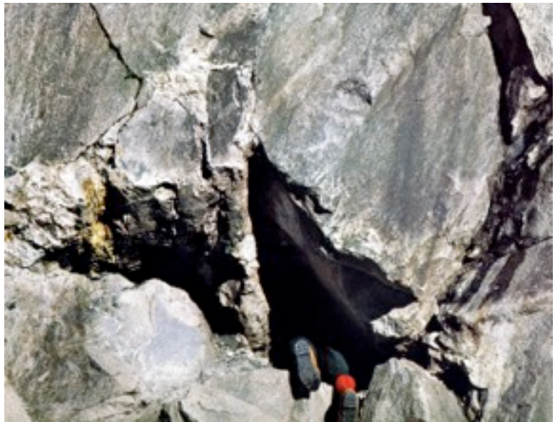
Une fissure alpine
